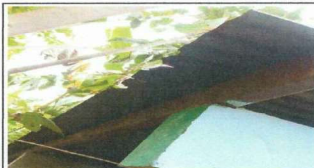
Foto 4: Sustrución de lámina normal por lamina troquelada aluzinc calibre 26. Módulo 2.
