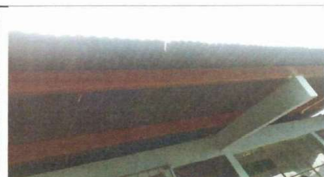
Foto 5: Sustrución de lámina normal por lamina troquelada aluzinc calibre 26. Módulo 2.
