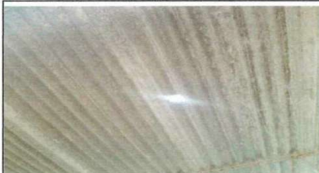
Foto 2: Sustrución de lámina normal por lamina troquelada aluzinc calibre 26. Módulo 1.
