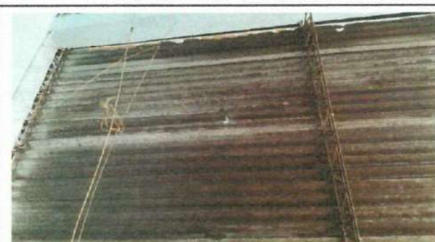
Foto 3: Sustrución de lámina normal por lamina troquelada aluzinc calibre 26. Módulo 1.
