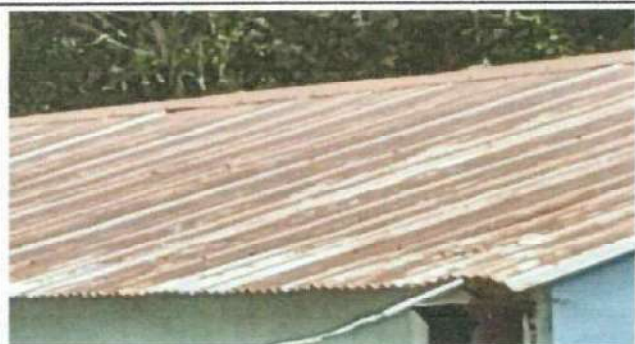
Foto 1: Sustrución de lámina normal por lamina troquelada aluzinc calibre 26. Módulo 1.
