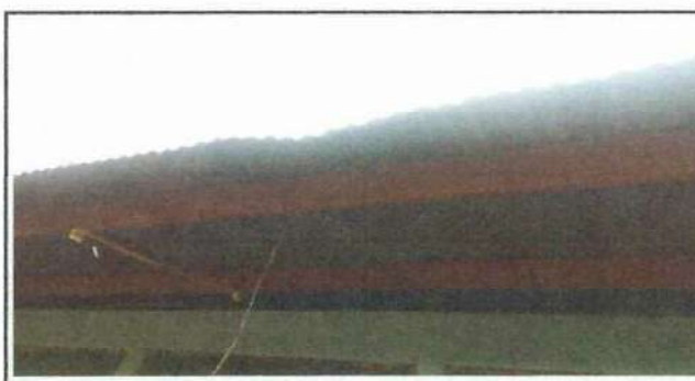
Foto 6: Sustrución de lámina normal por lamina troquelada aluzinc calibre 26. Módulo 2.
